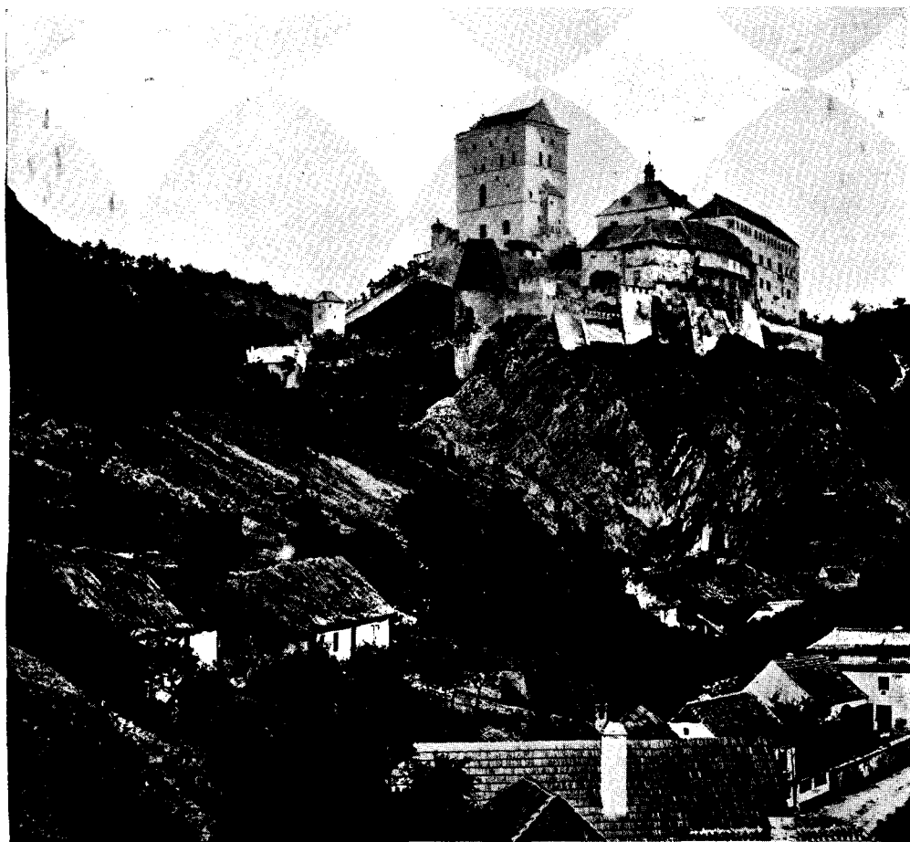
Karlův Týn před opravou.
